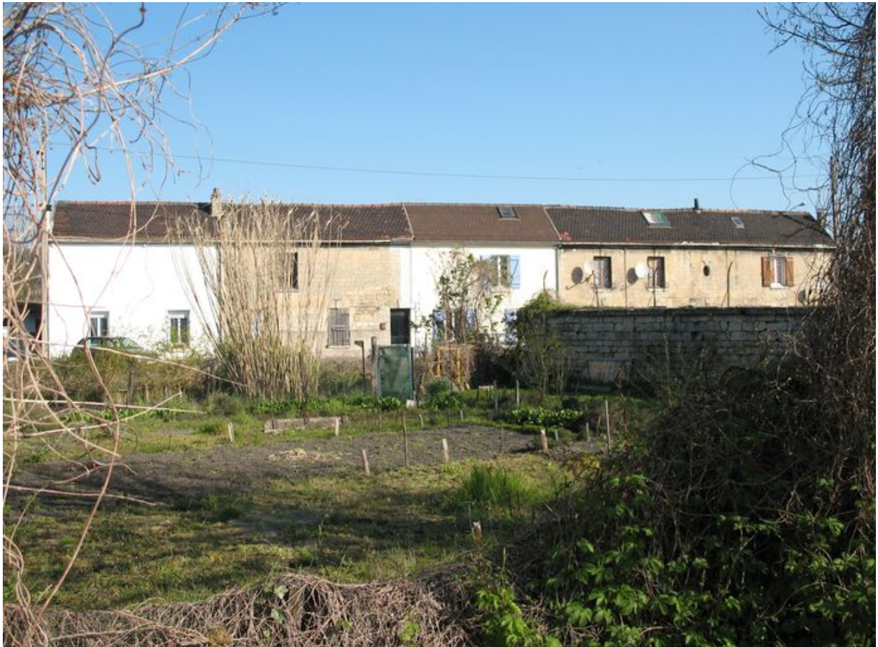
Vue rapprochée de la barre de logements.
