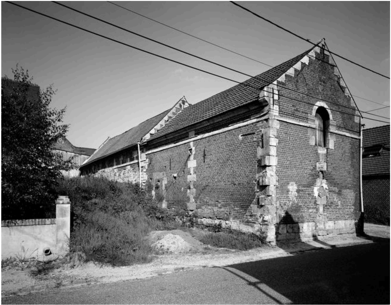
Vue générale postérieure.
