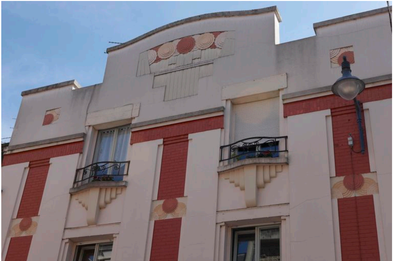
Ensemble des décors géométriques ornant la façade.
