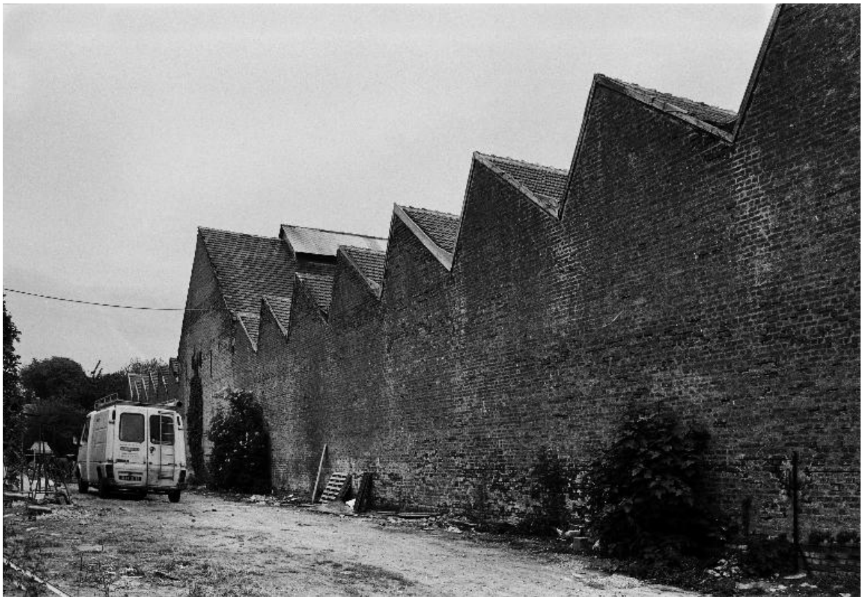
Atelier de fabrication, flanc est, en 1990.
