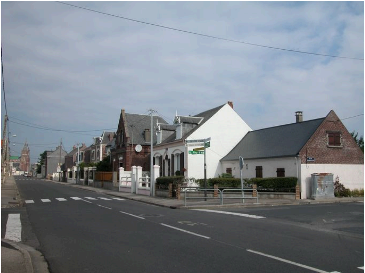
La rue du Maréchal-Foch, côté pair au delà de la rue du Chevalier-de-la-Barre.
