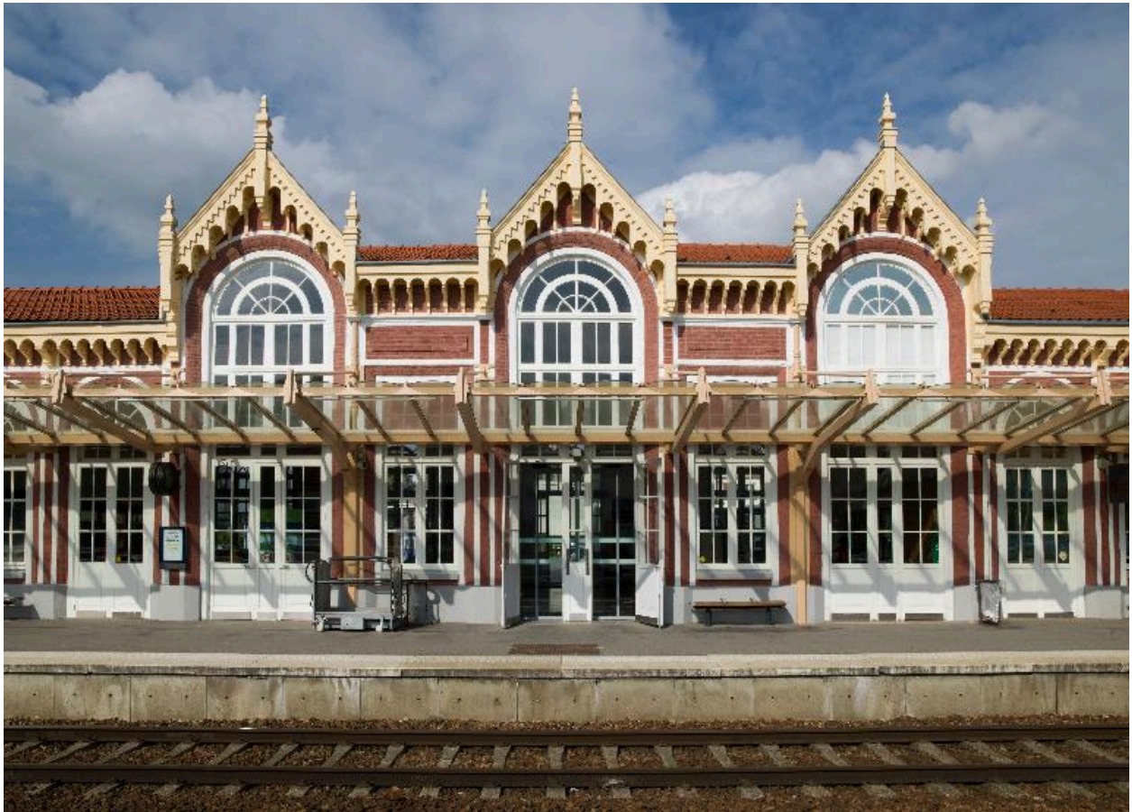
Vue du corps central côté quais.
