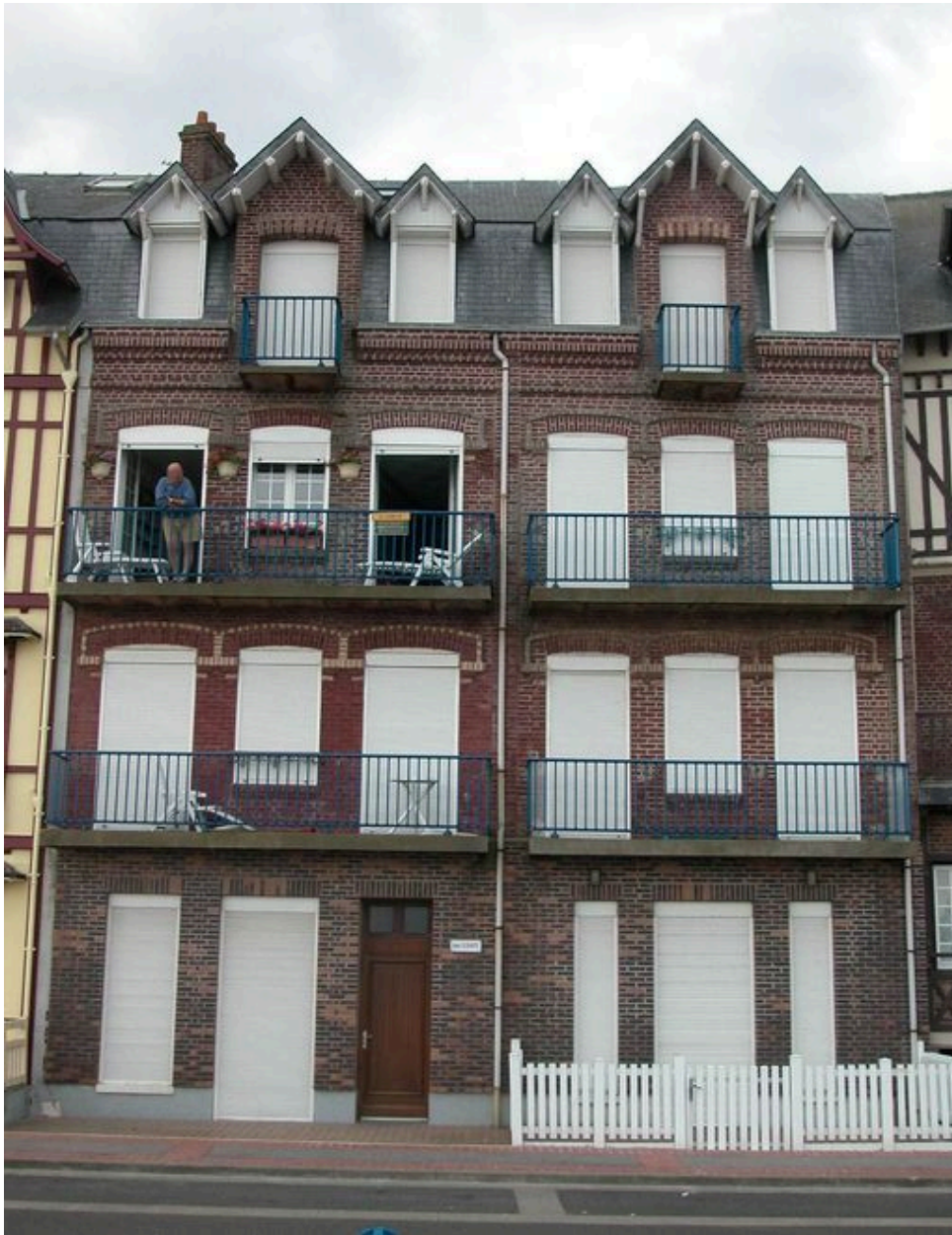
Vue d'ensemble, façade sur mer.
