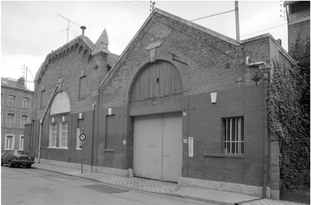
Atelier de fabrication et bureau.
