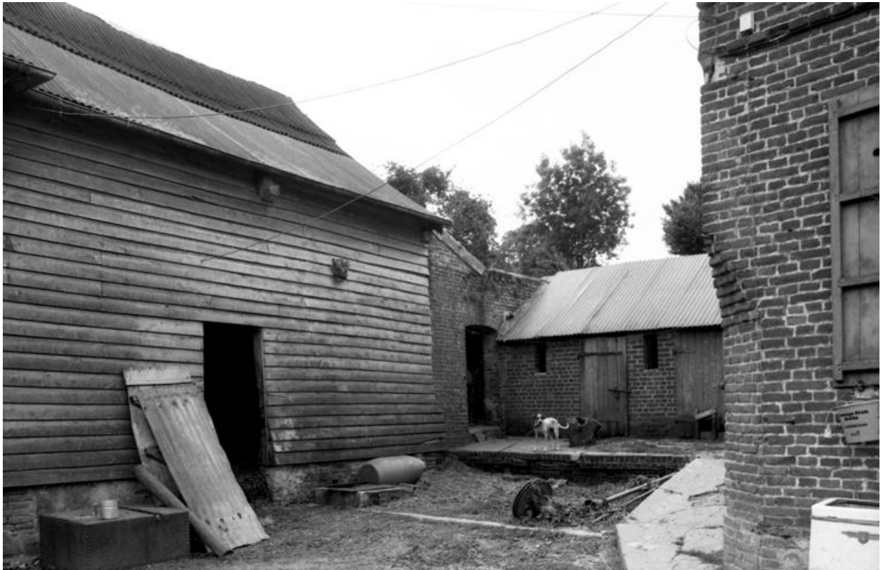
Vue d'ensemble de la grange et de l'étable attenante.
