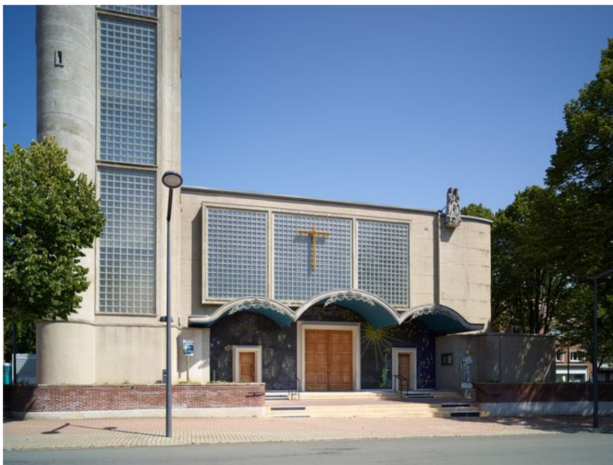
Détail de l'élévation antérieure de l'église.
