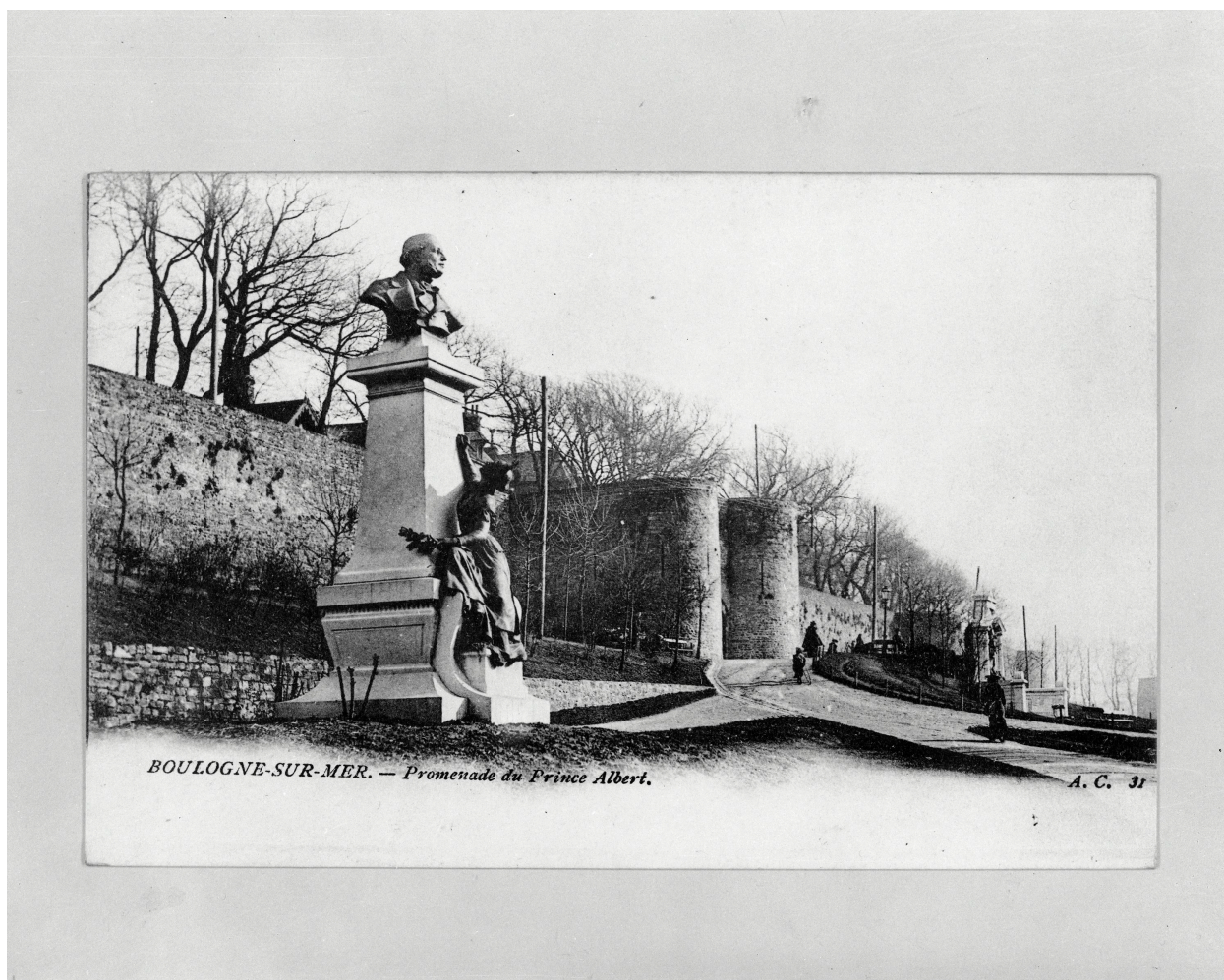
Vue d'ensemble avec porte des Degrès, A.D. Pas-de-Calais, division cartes postales.
