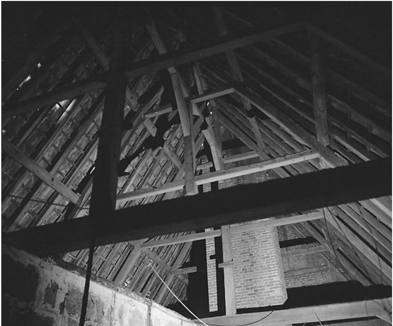
Intérieur, étage de comble : charpente, vue longitudinale vers l'est.
