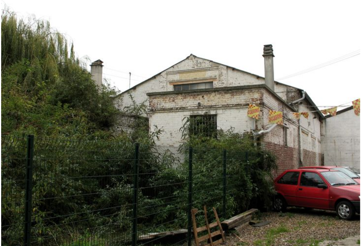
Le bâtiment de l'ancienne usine de matériel d'équipement industriel depuis la rue de Gournay.
