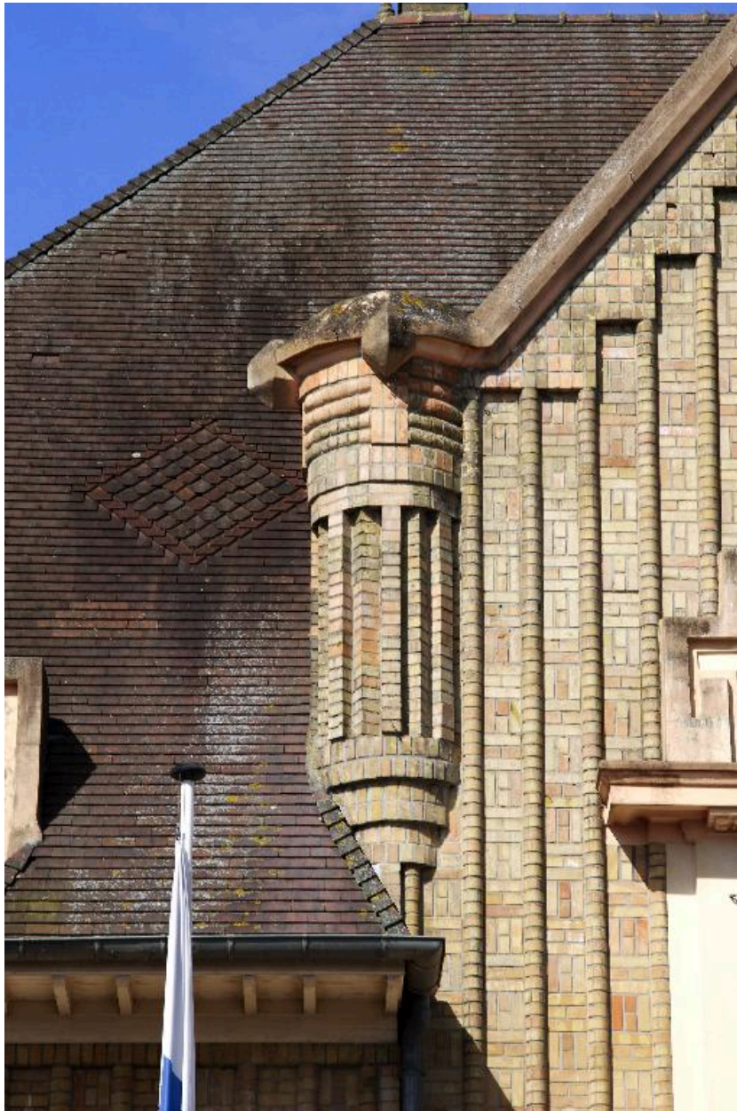
Détail de l'appareillage de briques de la façade principale.
