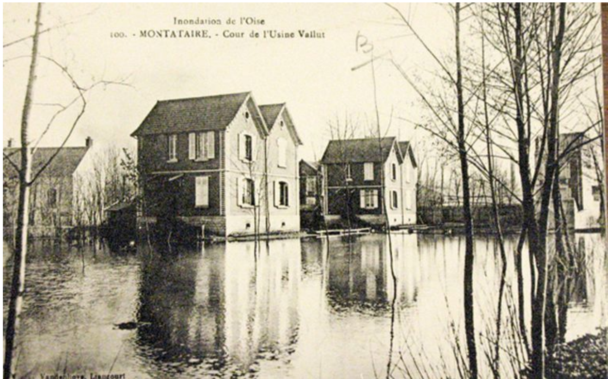
Les logements de contremaître inondés lors de la crue du Thérain en 1910 (archives d'entreprise).
