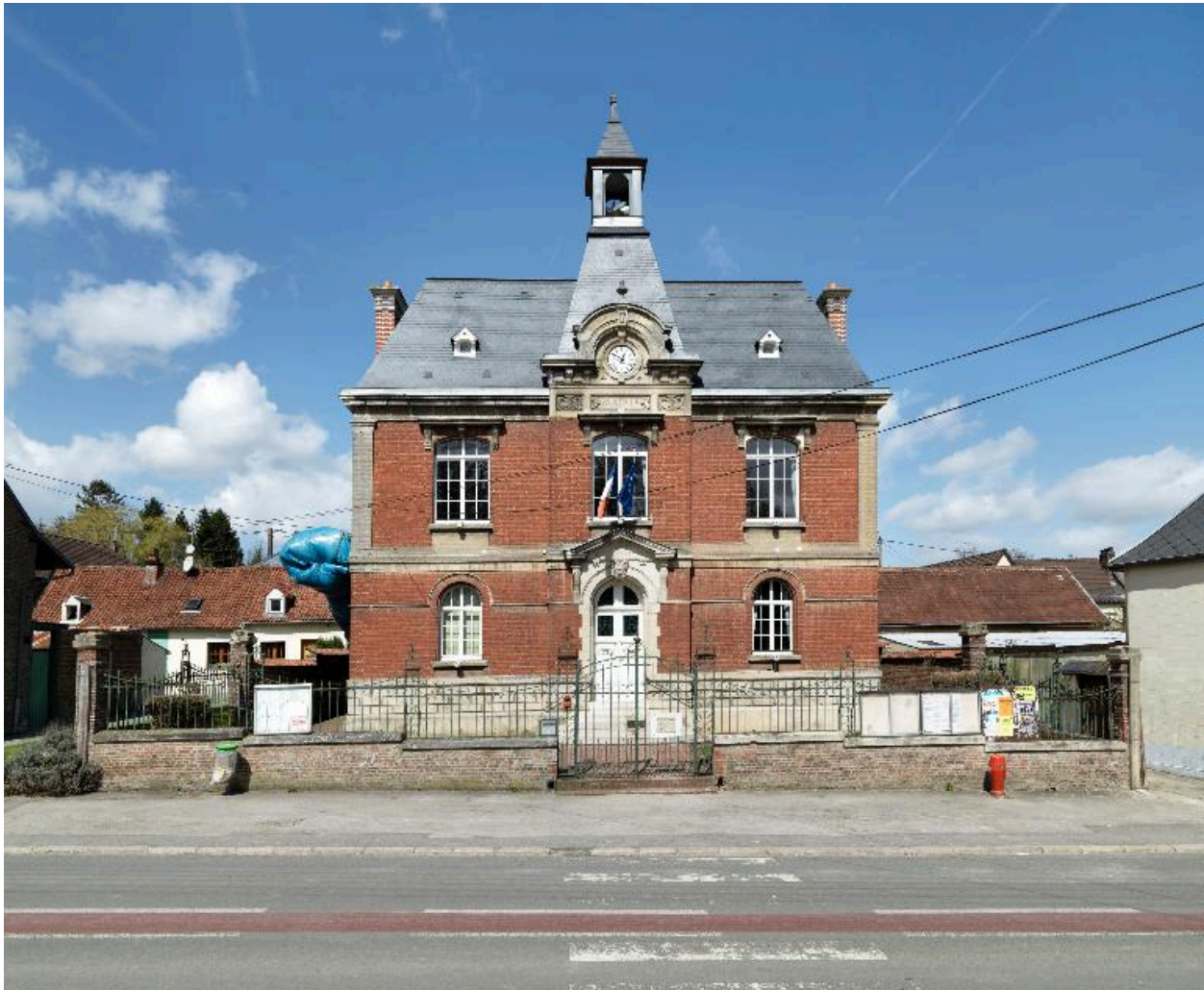
Vue d'ensemble de la façade sur rue.
