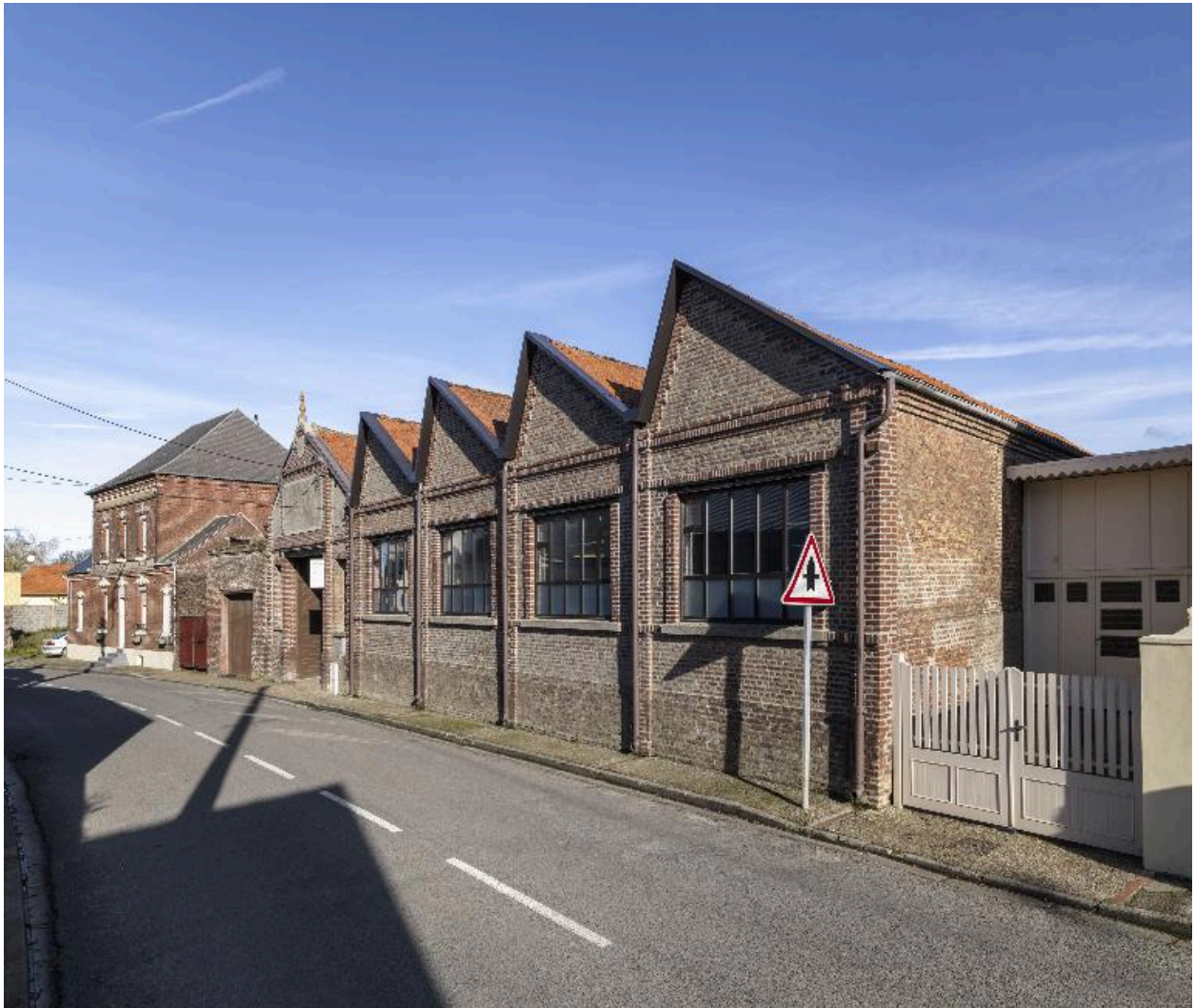
Vue générale du logement patronal et de l'atelier de fabrication principal.
