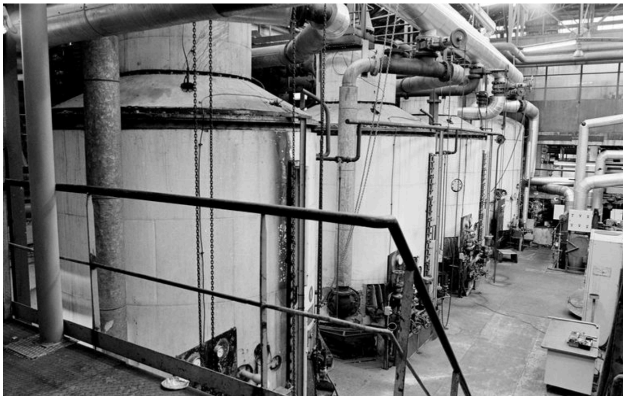
Atelier de fabrication (cristallisation) : vue intérieure.
