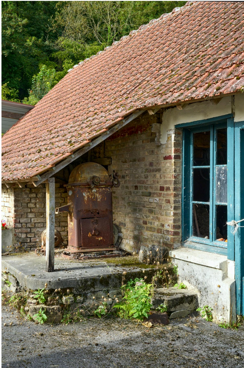
Ancienne pompe à eau, 16 rue de Vieulaines.
