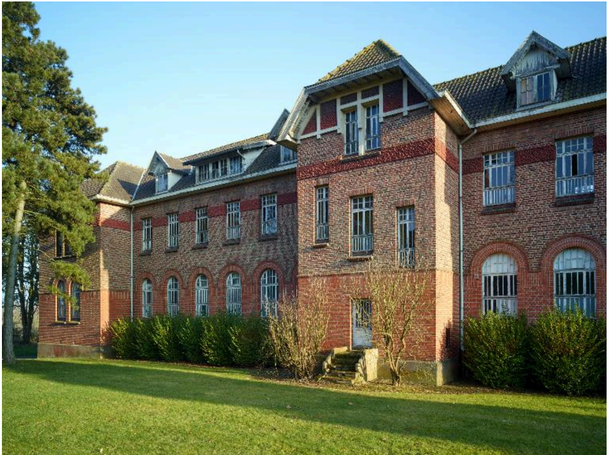
Bâtiment d'hospitalisation dit pavillon D9, élévation antérieure, détail de la moitié gauche.
