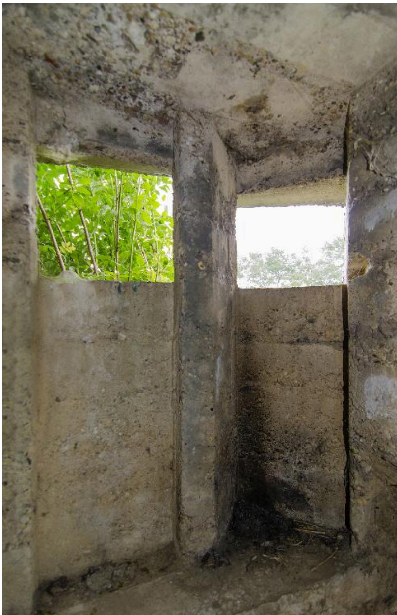
Intérieur du poste d'observation (au grand angulaire)
