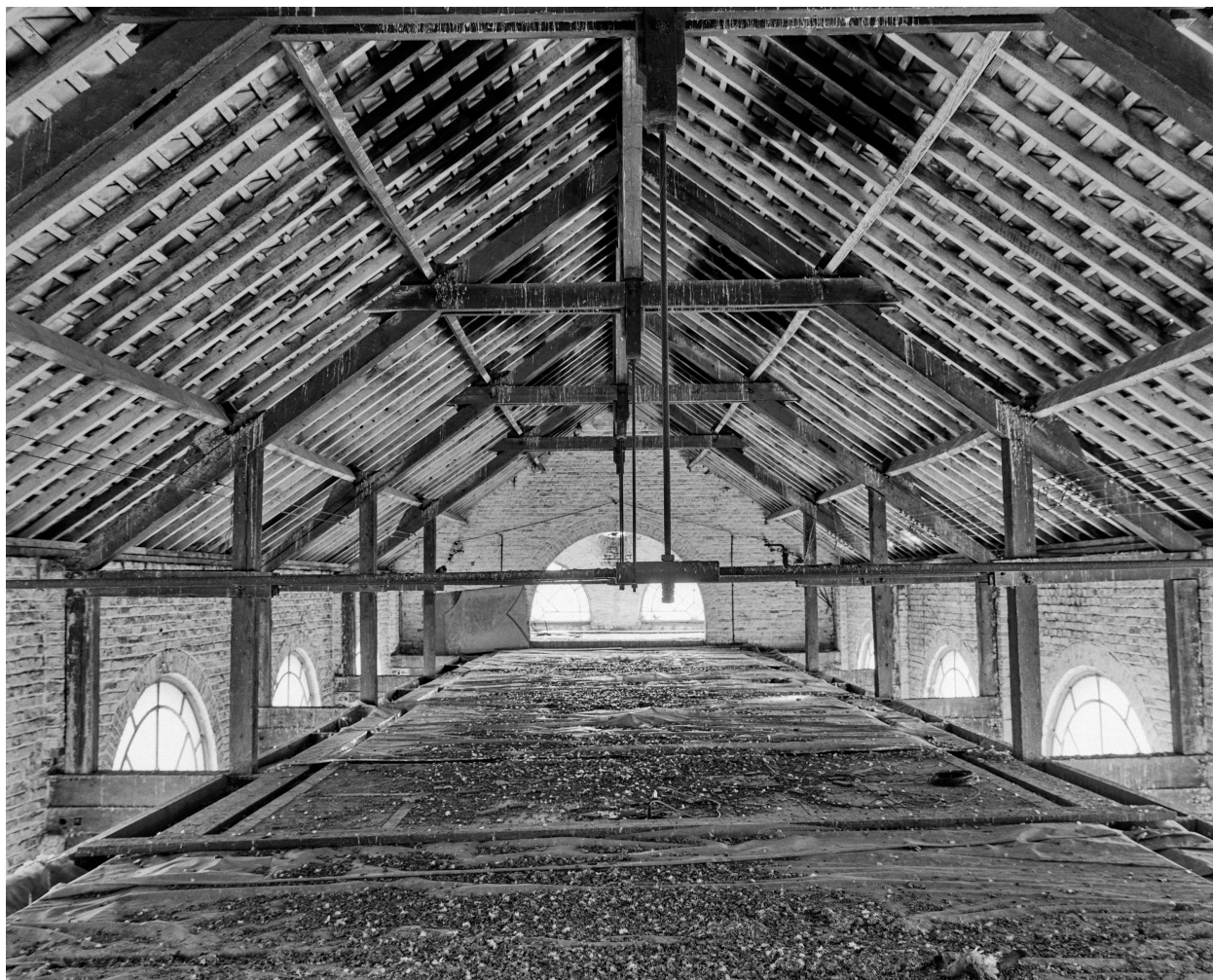
Vue générale des combles.
