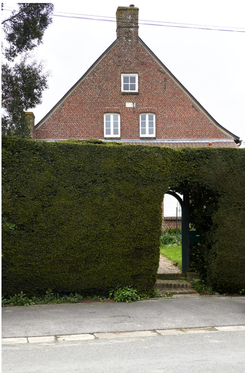
Clôture végétale et sommet du pignon sud de l'ancien presbytère.
