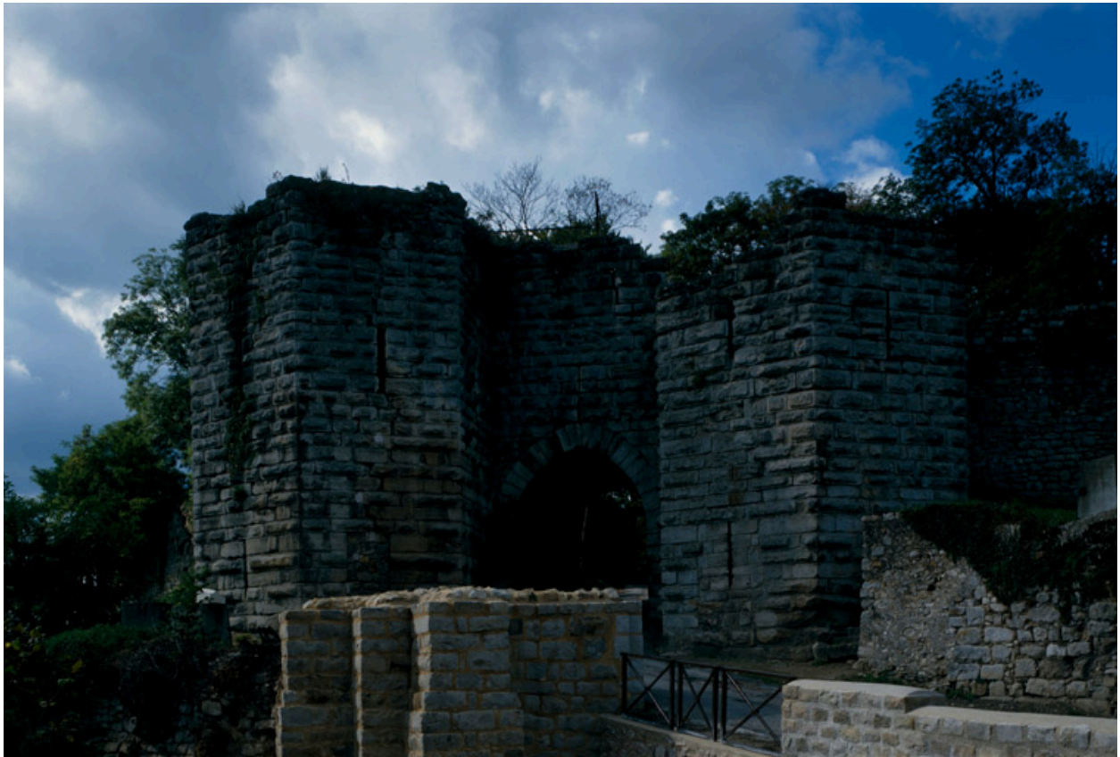
La porte Saint-Jean, depuis le 33 rue du Château.
