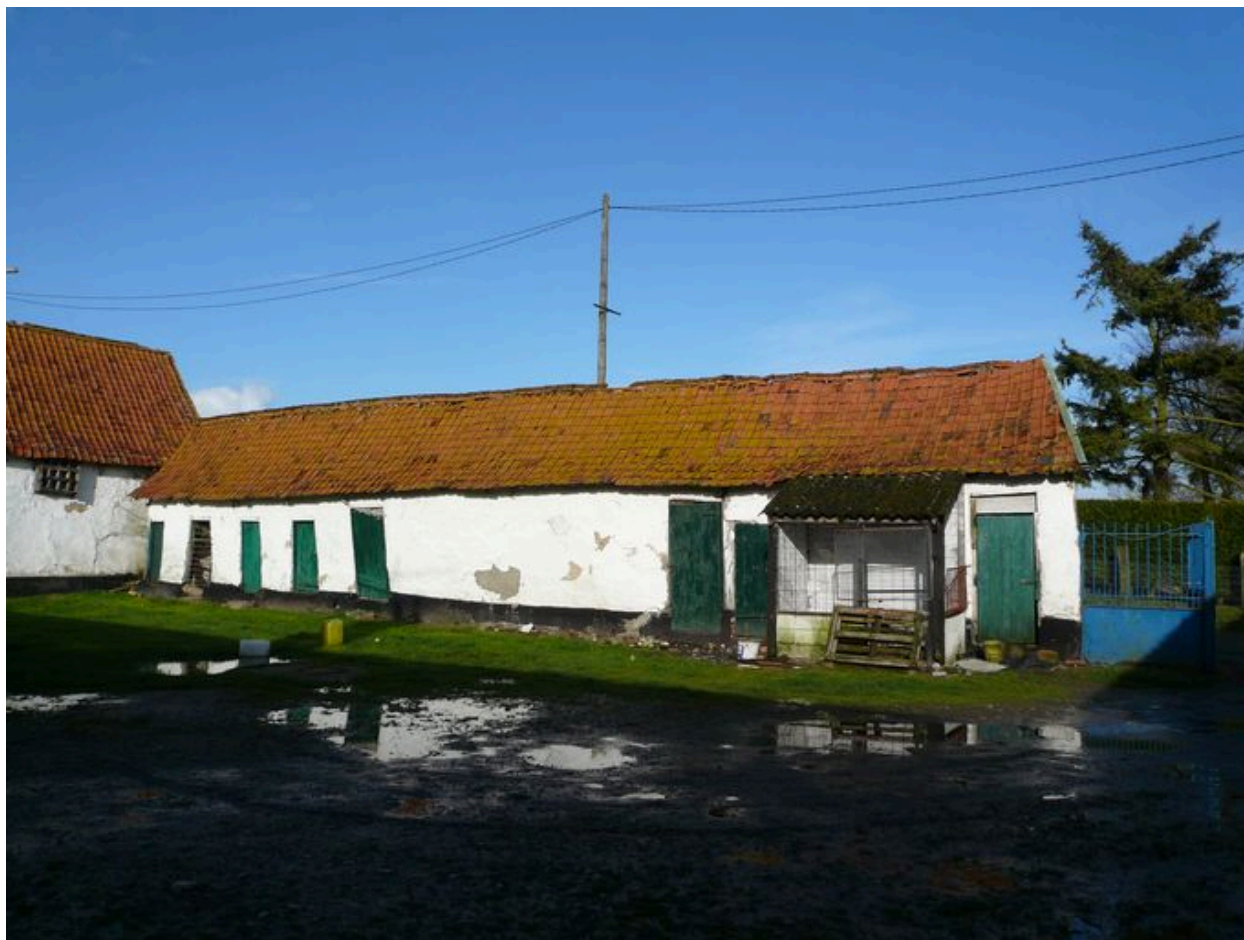
Vue des étables à cochons sur rue.
