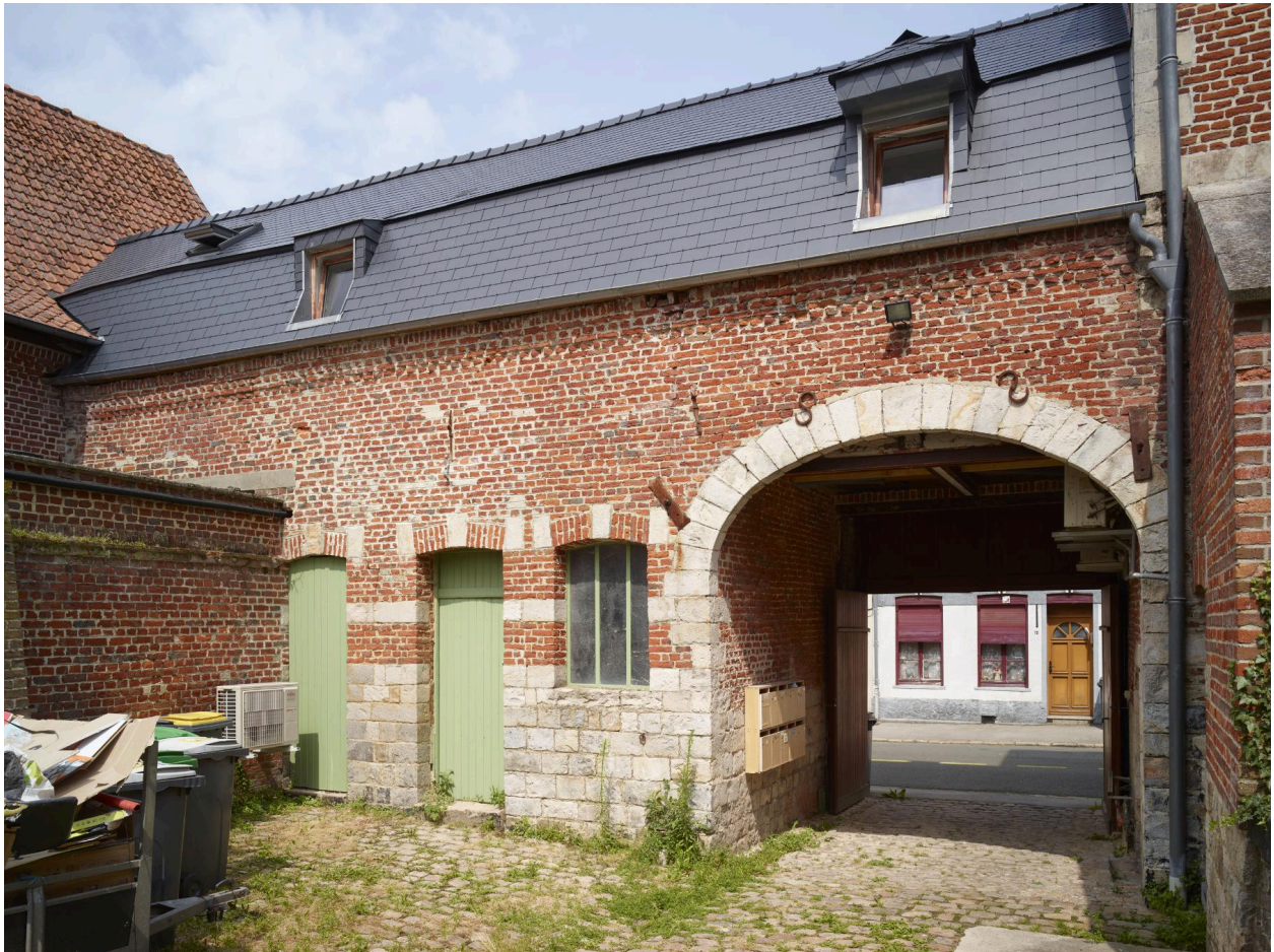
Façade arrière de l'aile incluant le passage couvert.
