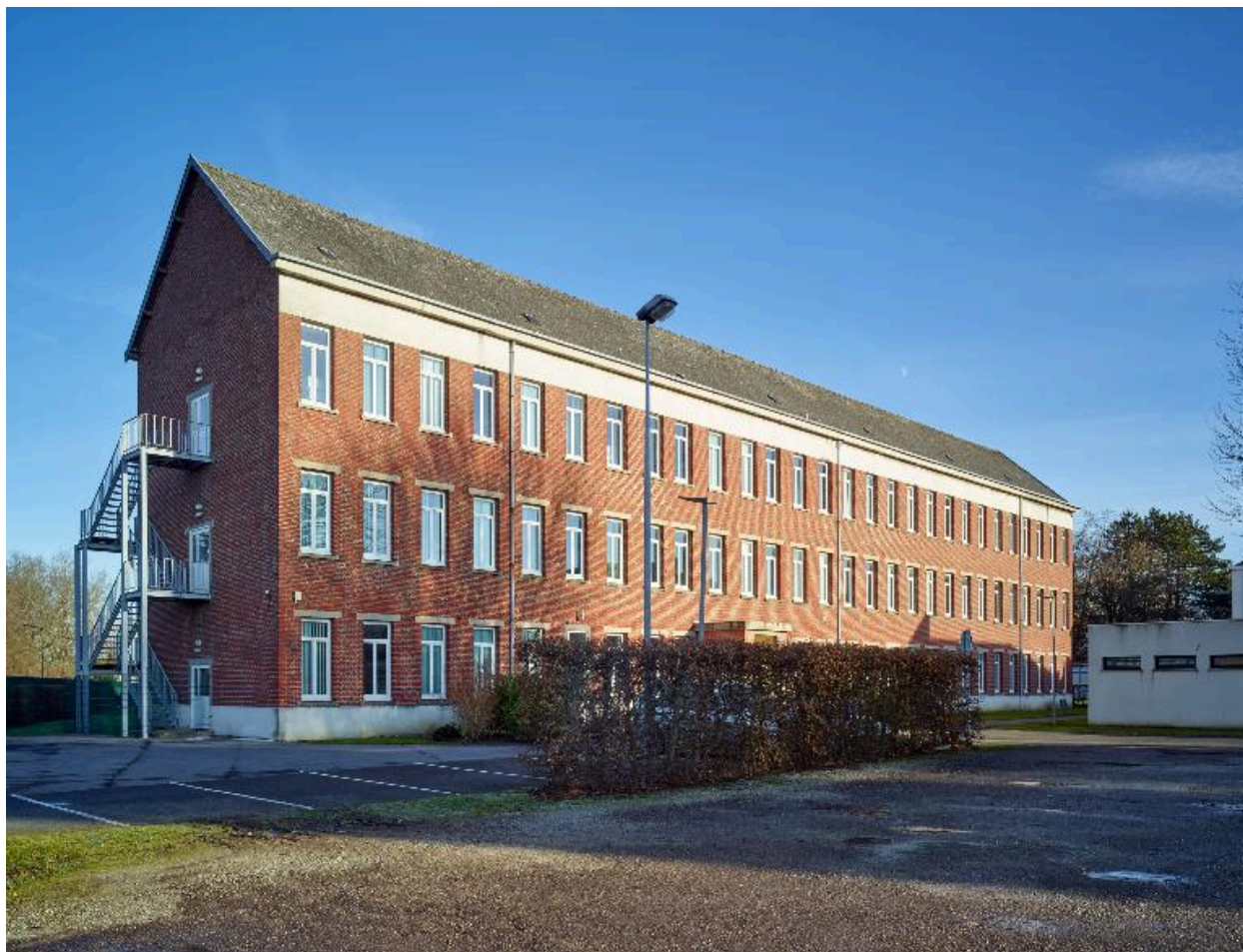
Bâtiment d'hospitalisation dit pavillon 5 bis, élévation antérieure, vue générale prise de trois quarts gauche.
