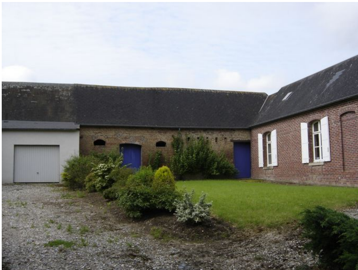
Vue des étables depuis la rue.
