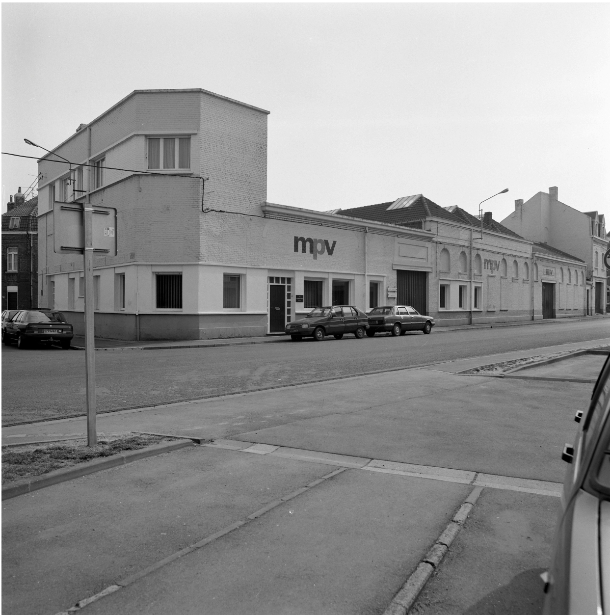
Enfilade rue des Chauffours, vue prise vers l'ouest.
