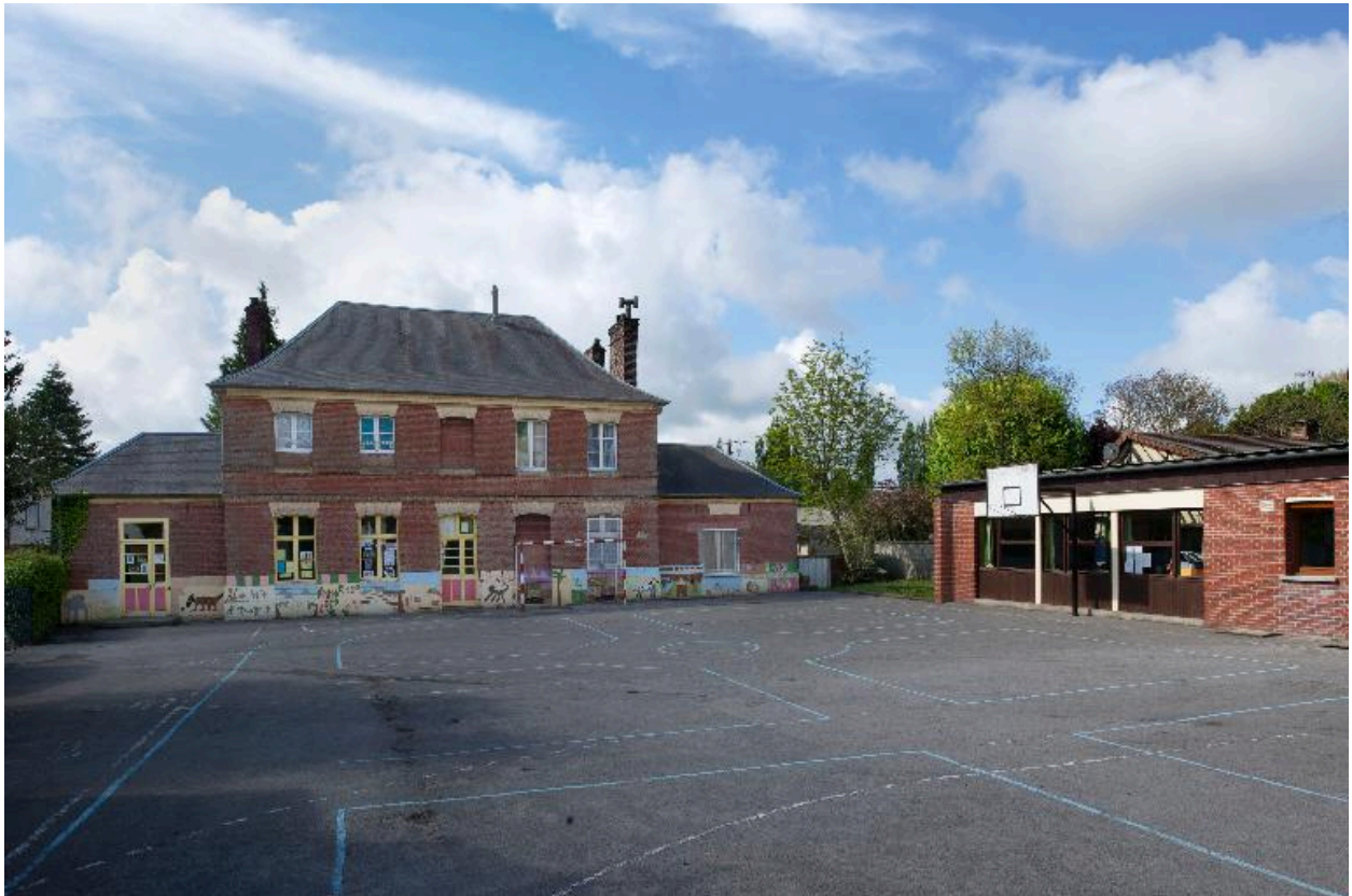
Vue générale depuis la cour de récréation, au nord.
