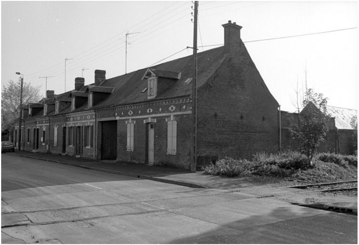
Logement d'ouvriers, élévation antérieure.
