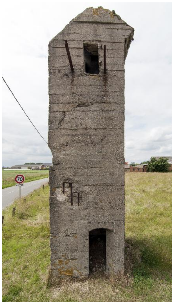
Vue frontale de l'observatoire vers le nord-ouest
