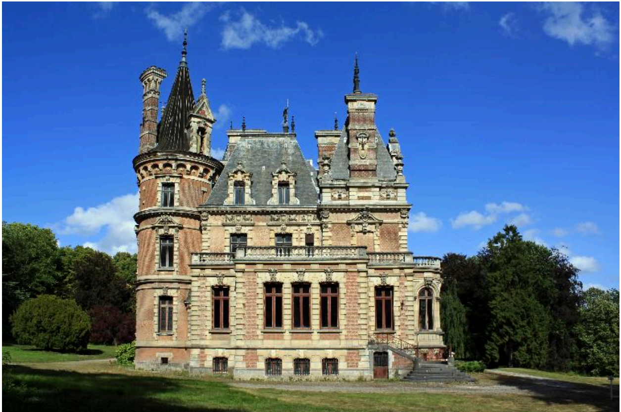
Façade latérale ouest du château.
