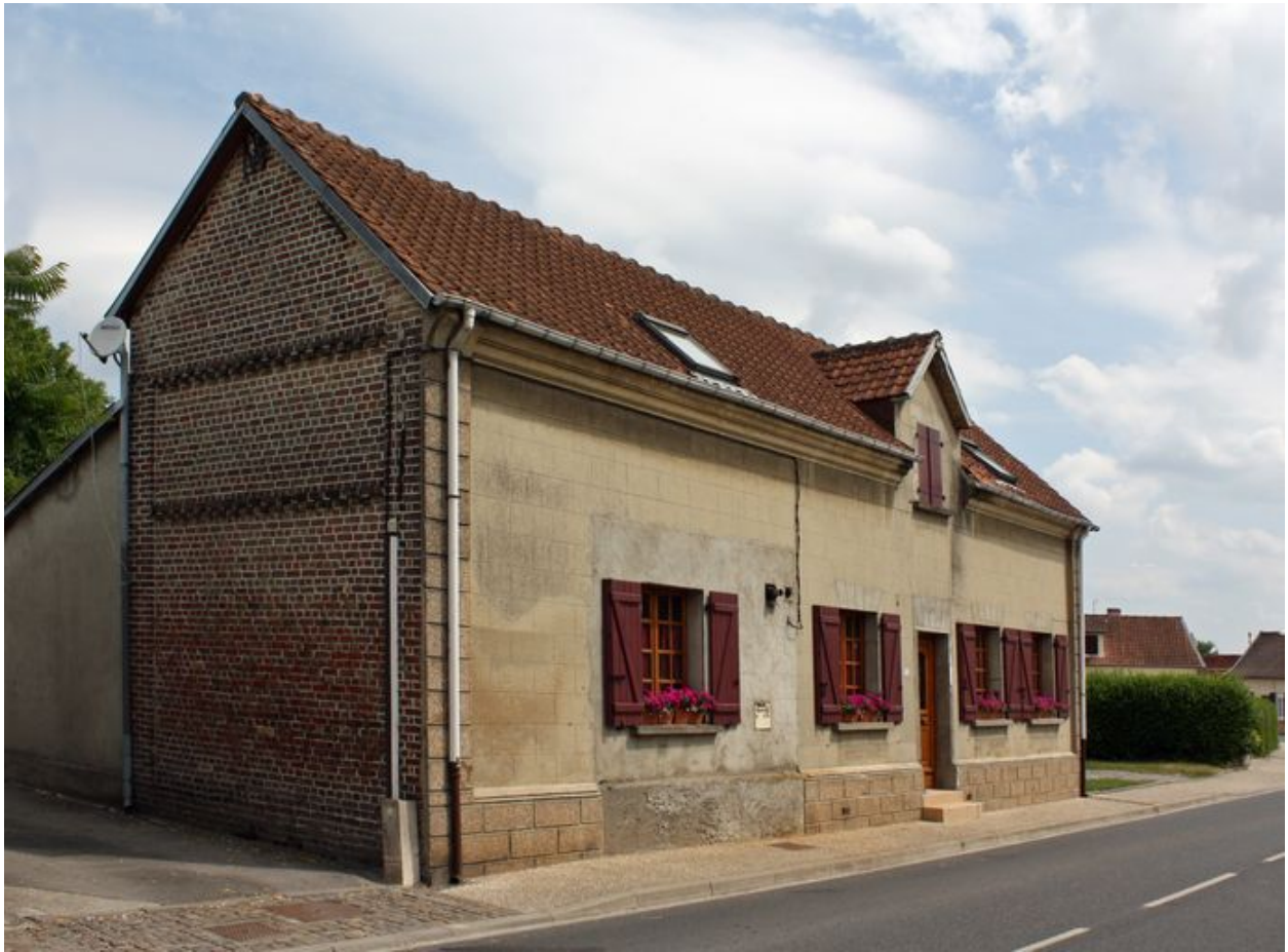
Vue d'ensemble sur rue.
