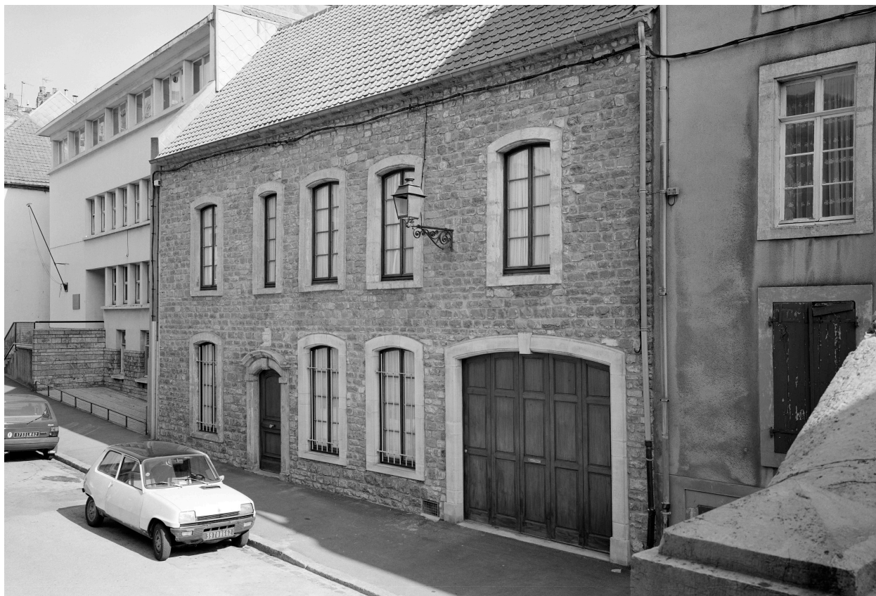
Vue générale sur voie.
