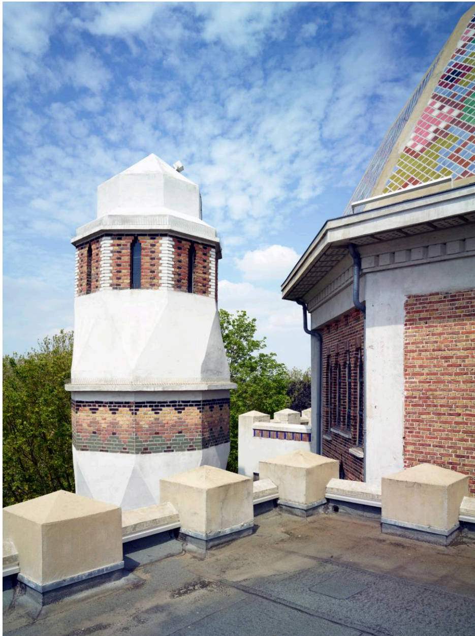
Couronnement de la tourelle du transept au sud.
