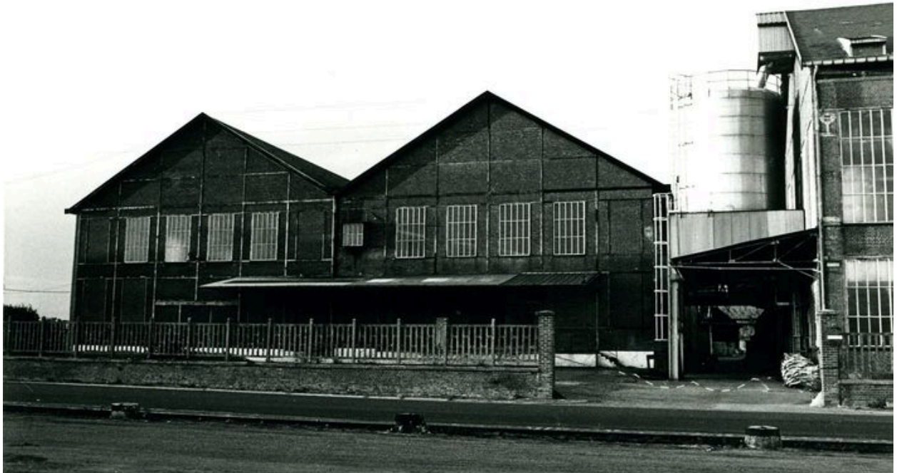
Atelier de fabrication, flanc sud.
