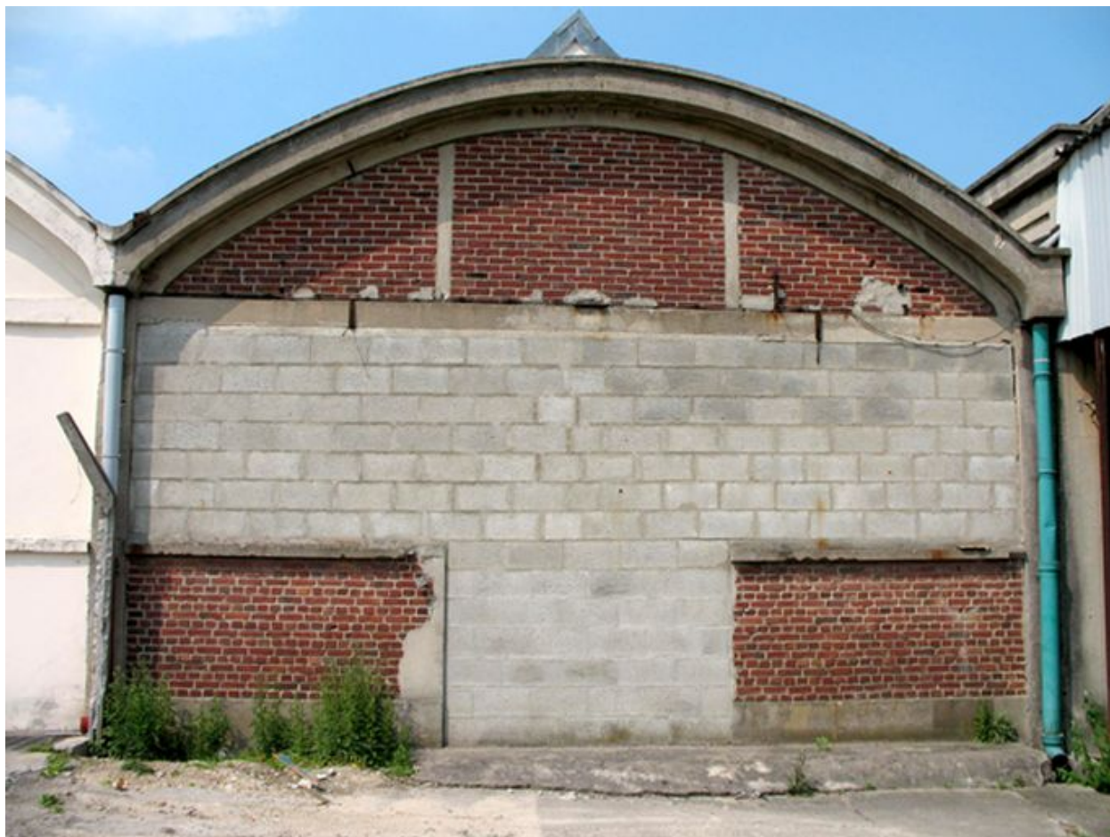
Détail d'une travées des ateliers de fabrication.
