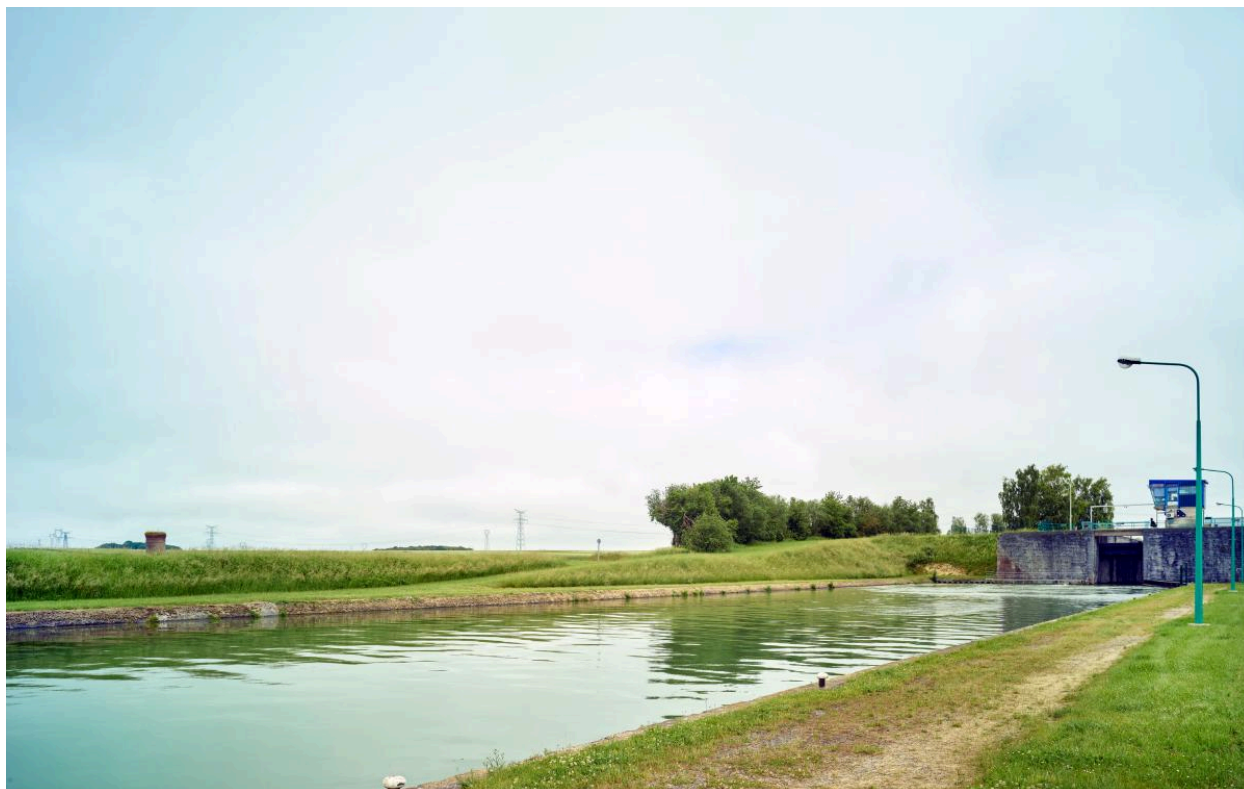
Vue générale de la tête aval du site.
