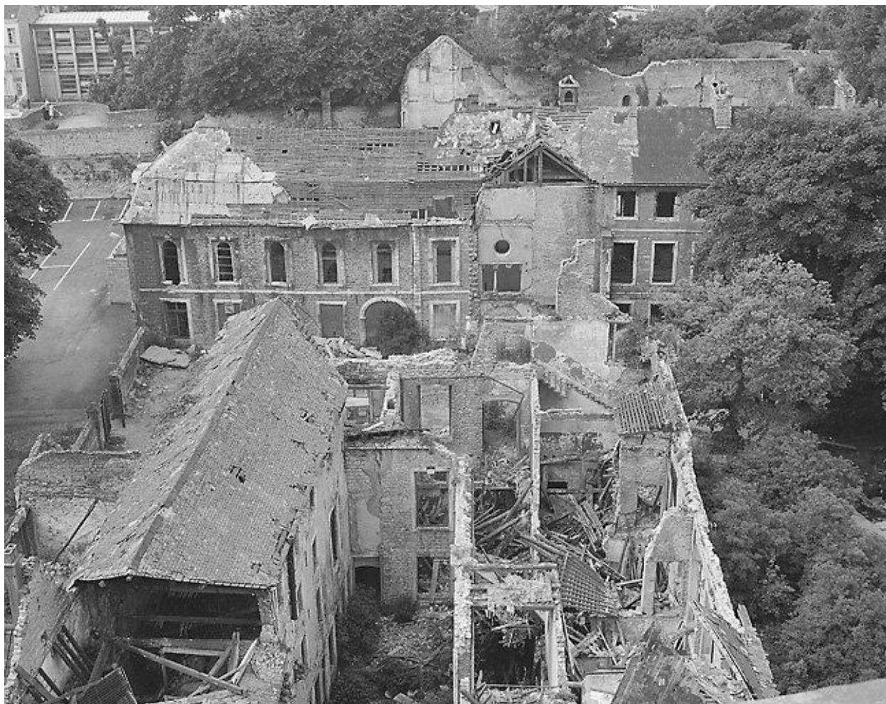
Vue générale aérienne du dôme de l'Eglise.
