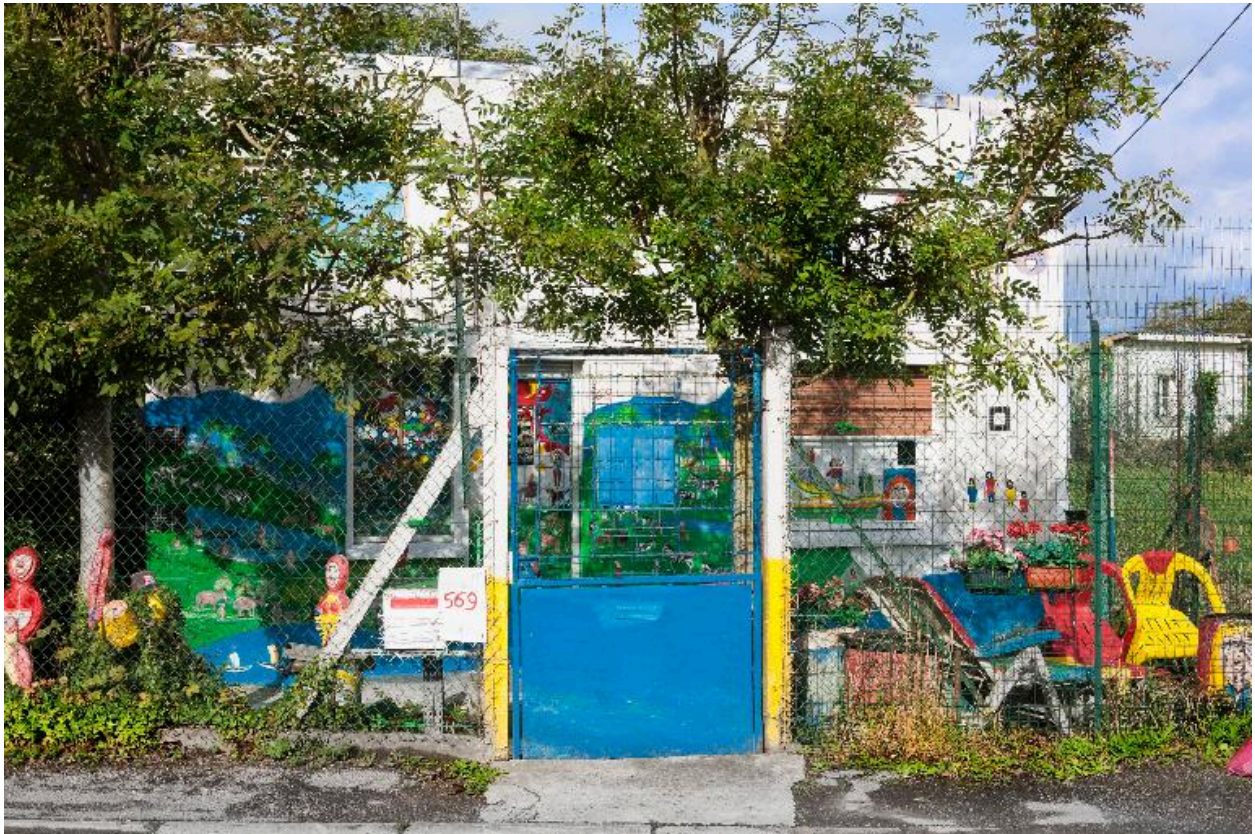
Vue générale sur rue, de front.
