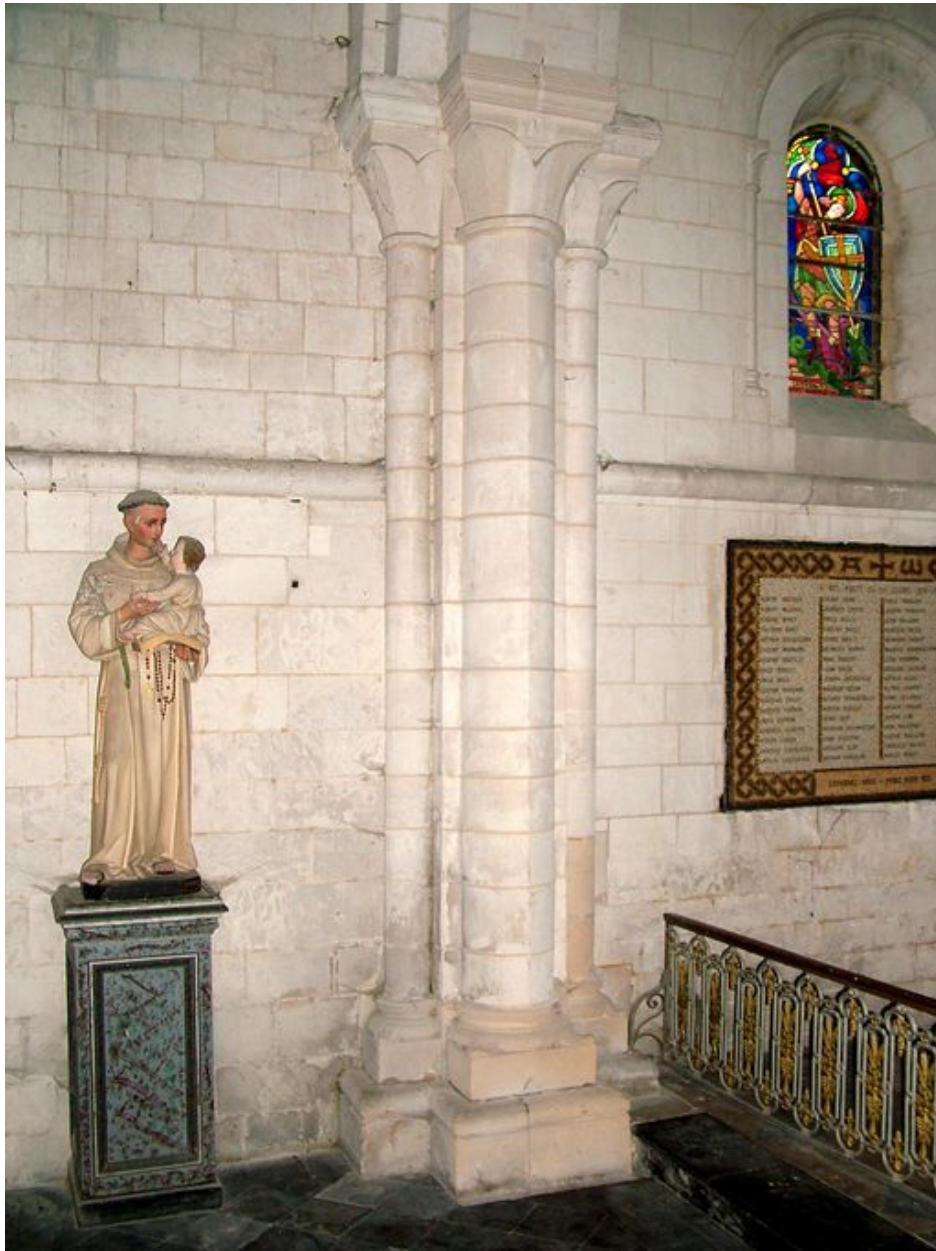
Pilier engagé au revers de la façade occidentale.
