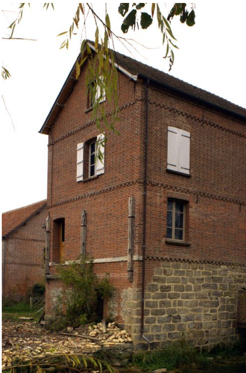
Elévation nord-est du moulin.
