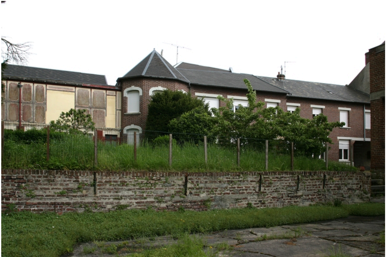
Logement patronal : façade antérieure.
