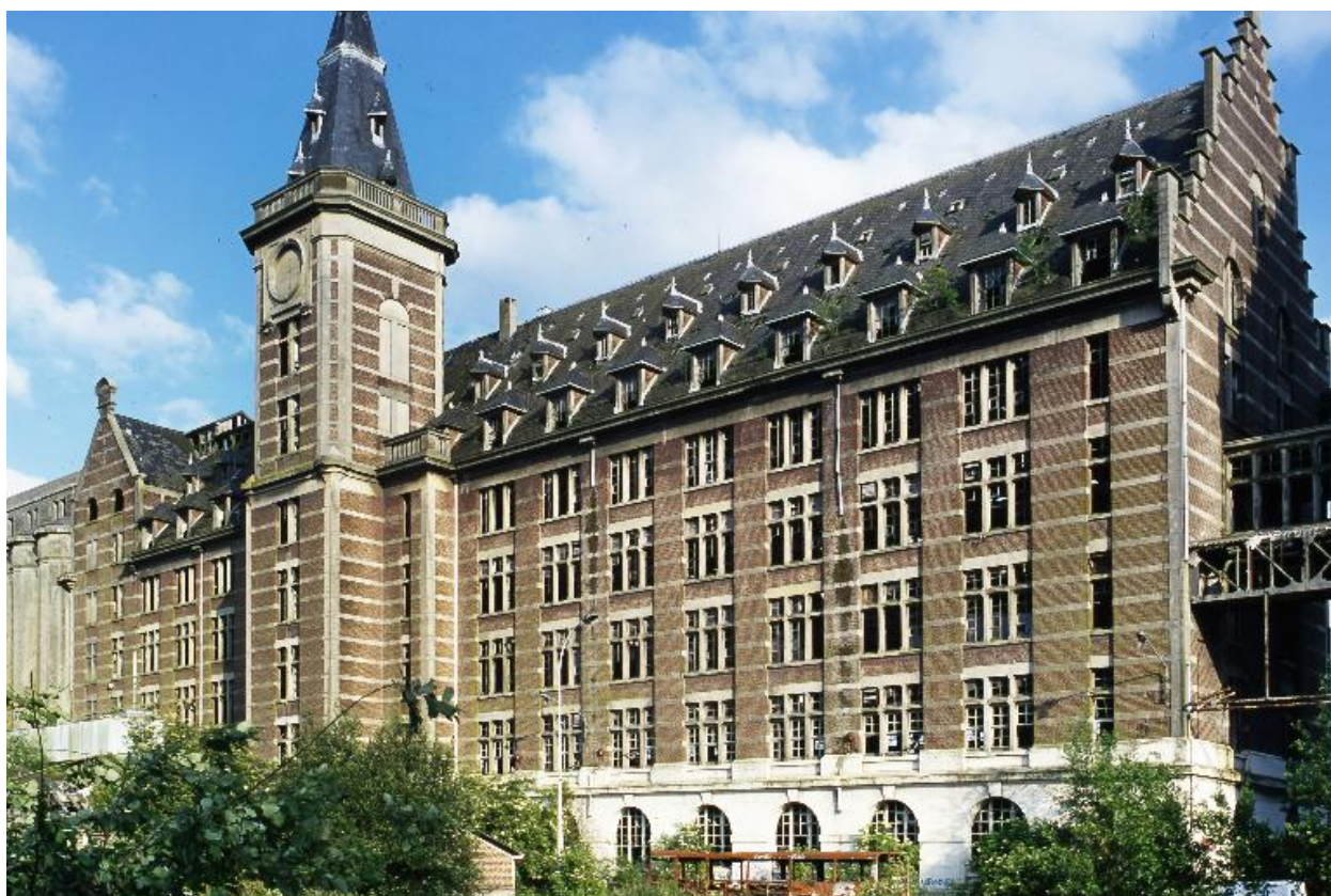
Élévation nord de la minoterie.
