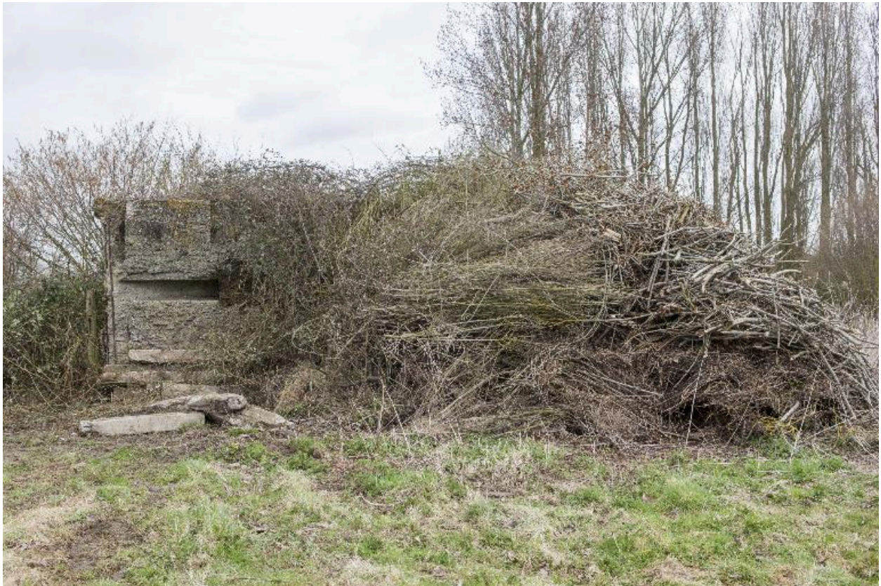
Vue latérale, vers le nord
