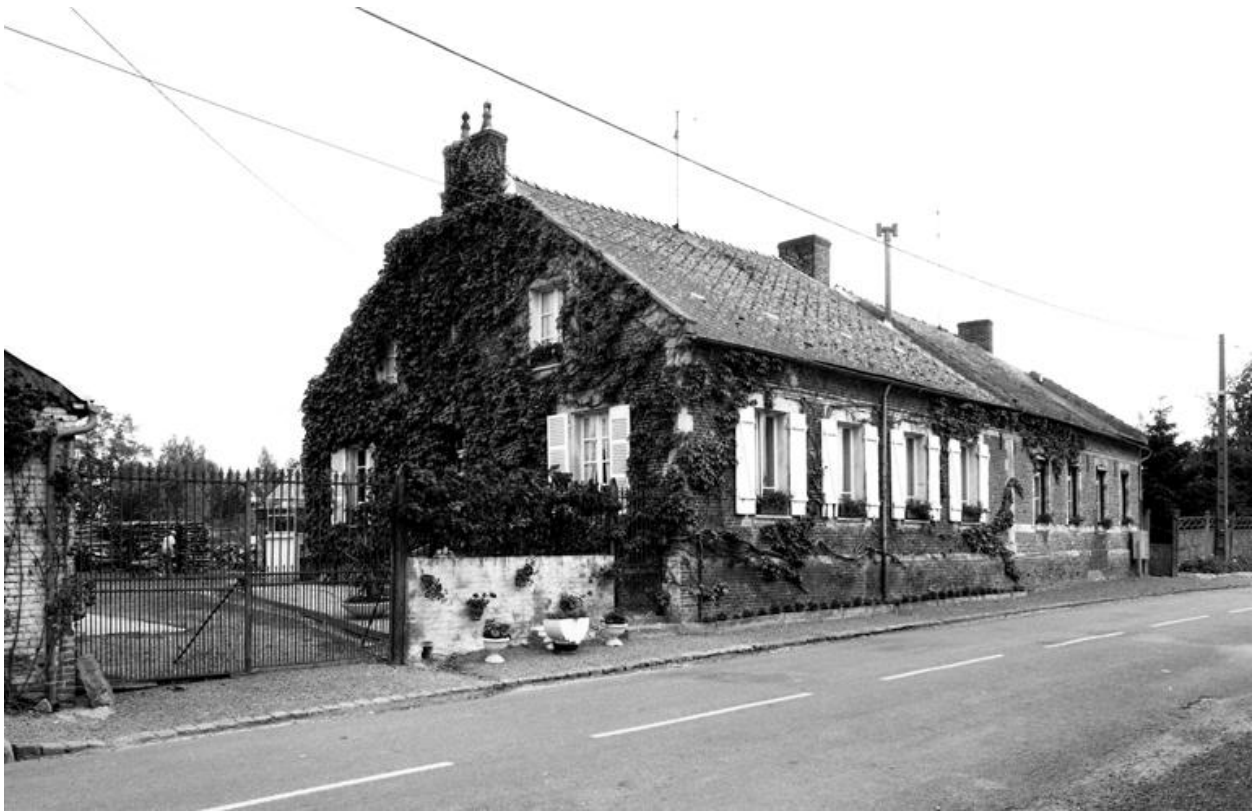
Vue d'ensemble du logis, depuis le sud-ouest.
