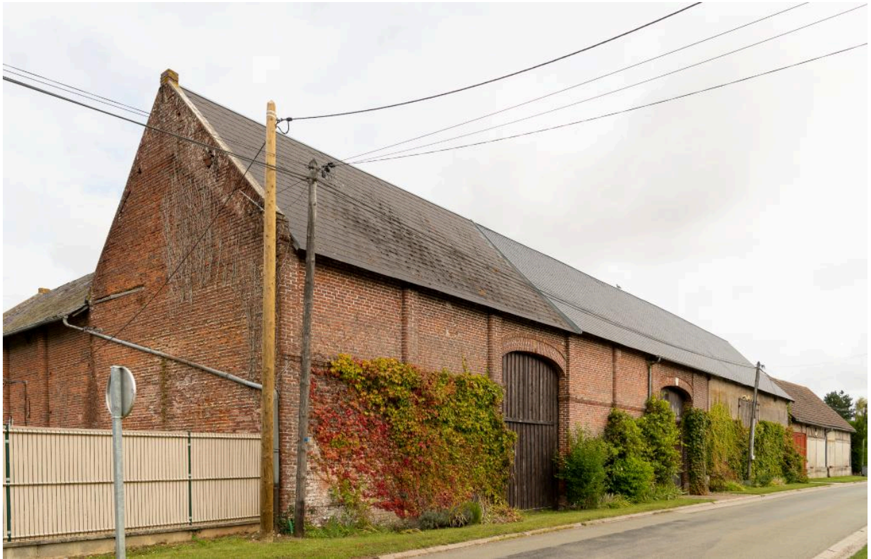
Vue des bâtiments agricoles alignés sur la rue depuis le sud-ouest.
