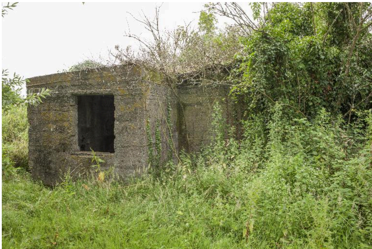
Casemate a), élévation ouest
