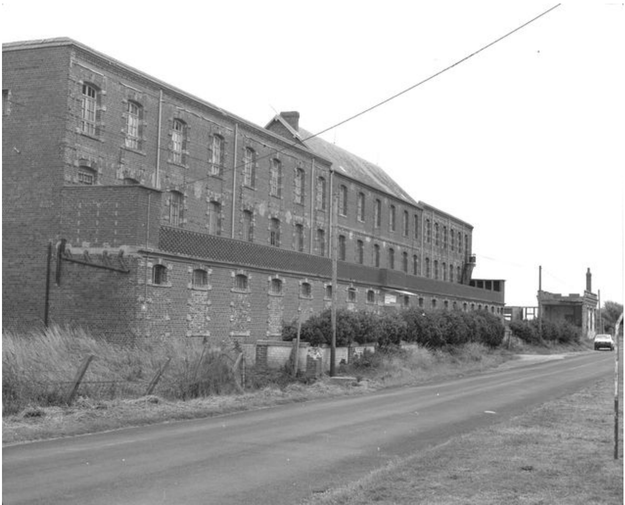
Corps de logis principal, élévation antérieure donnant sur le chemin des Anglais, vue de trois-quarts gauche.
